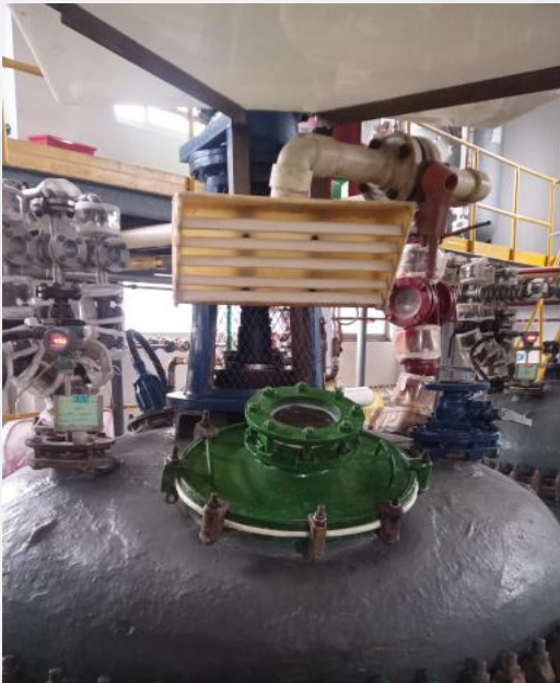
设备安装吸气罩
