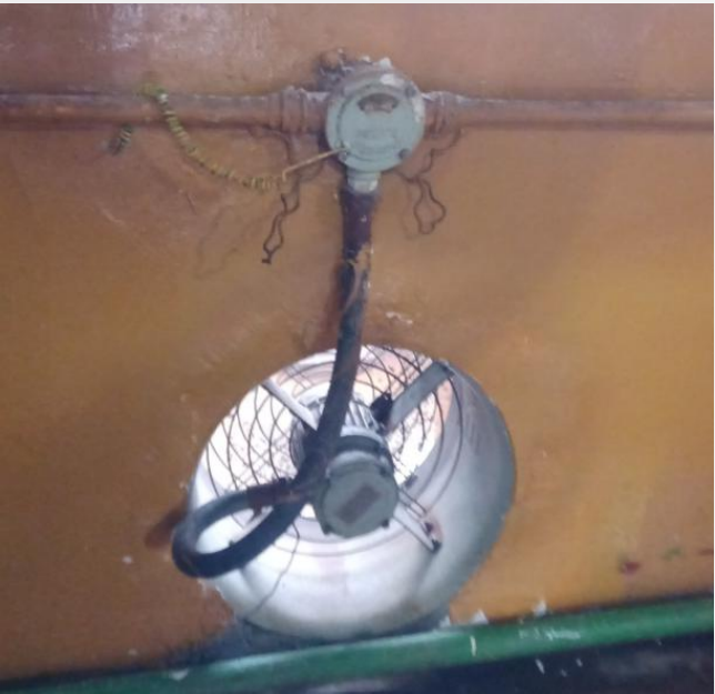
墙体安装排风扇
